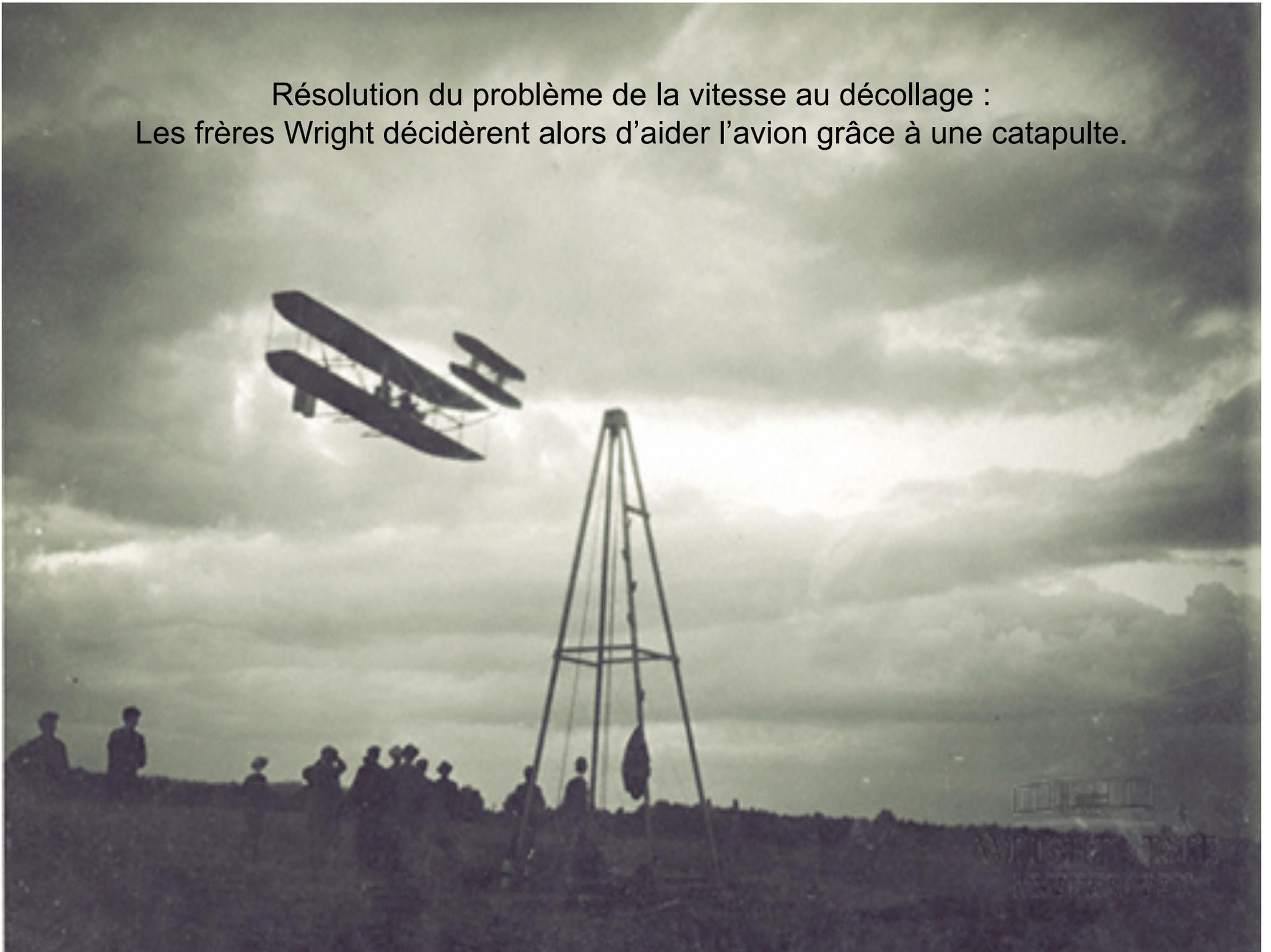
Cette catapulte était un derrick de bois, une masse de 600 à 650 kg était suspendue en haut du derrick d'une hauteur approximative de 6 m par un ruban relié au nez de l'avion par un système de poulies.
